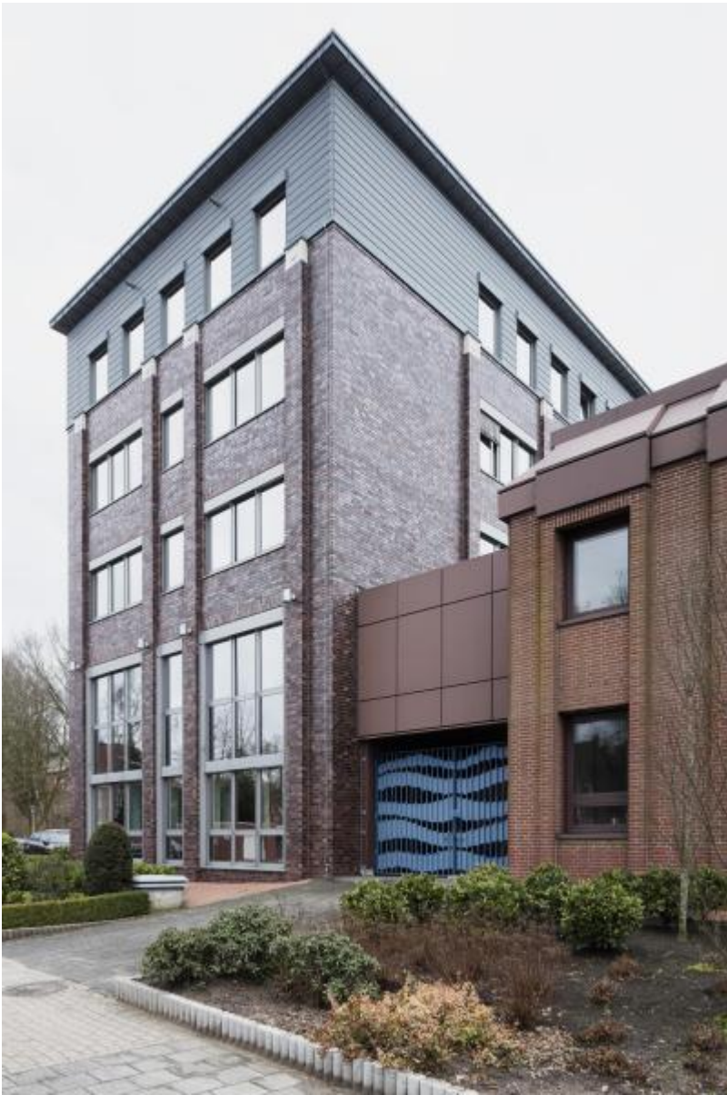
Klaus Böselmann: o. T. (Toranlage), 1983 / © Klaus Böselmann; Fotonachweis: BBR / Cordia Schlegelmilch (2017)
